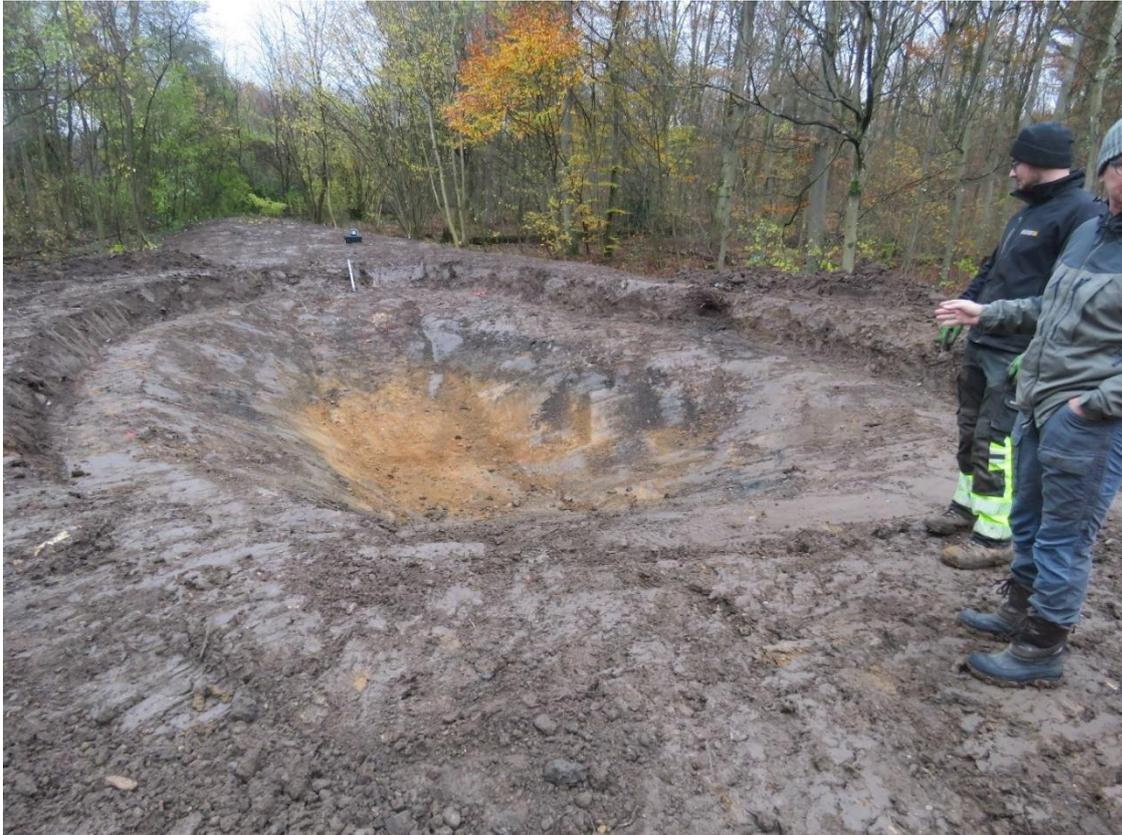
*Der Aushub des hinteren Weihers ist gemacht und bereit zum Ausmessen der Kautschukfolie. Der Weiher kommt etwas erhöht hinter dem Damm zu liegen, da eine grosszügige Ablagerung von Humus und Bauschutt zum Vorschein kam.*
