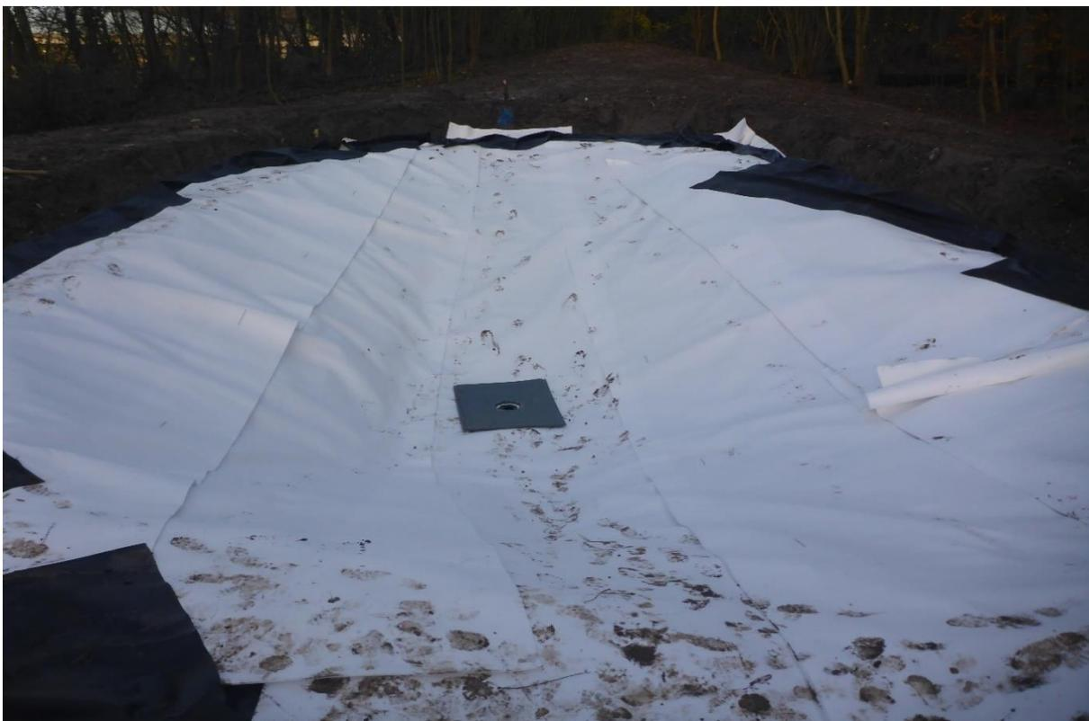
*Die vorkonfektionierte Weiherfolie wurde am 29.11.2023 verlegt und mit einem weissen Vlies jeweils unterhalb und oberhalb geschützt. Ausserdem wurde der Ablauf in der Mitte des Weihers gesetzt, nun kommt noch der Betonschacht.*
